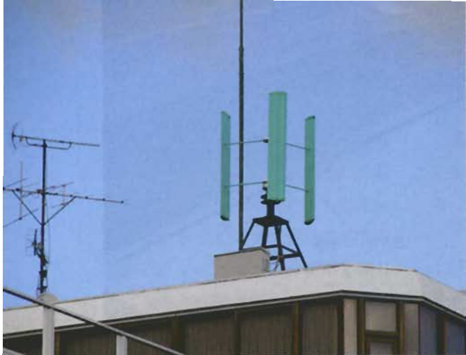
図4 ● ミズノテクニクスが試作した小型風力発電機 回転軸が鉛直方向を向いていることから「垂直型」と呼ばれる。全方向の風を生かせることが特徴。
