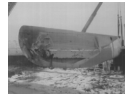
図: 落雷を受けた風車のブレード
