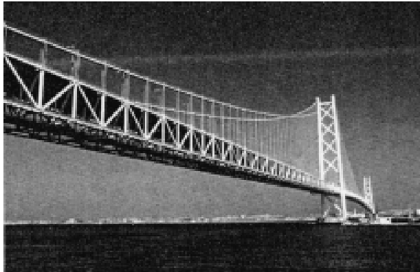
図4. 明石海峡大橋
