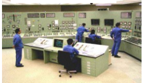
BWR中央制御盤の様子
