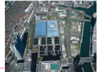
芝浦水再生センター (東京都下水道局)
