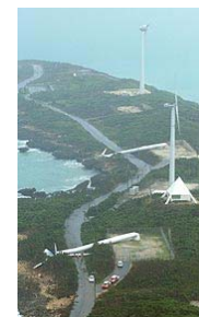
台風14号による風車被害
