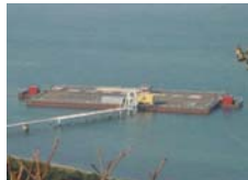
南淡うずしおメガフロート L101m x B60m x D3m
