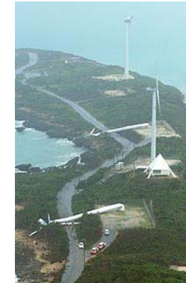
台風14号による風車被害
