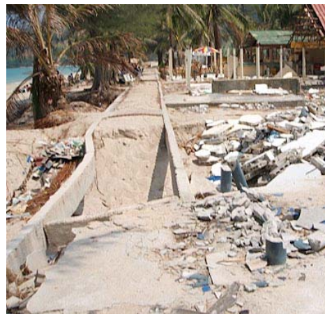
インド洋津波の被害を受けた プーケット島の海岸
